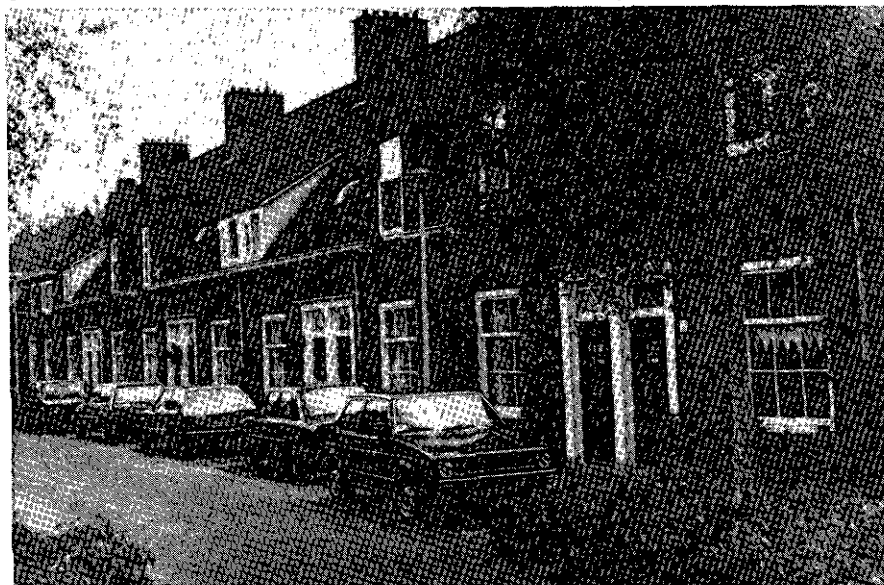
9 woningwetwoningen Vijfherenstraat (1947). Architect J.Th.Peper
