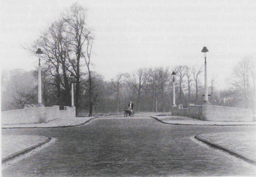
De Beukenvaartbrug in de Bijwelaan, kort na gereedkomen in de jaren dertig.
