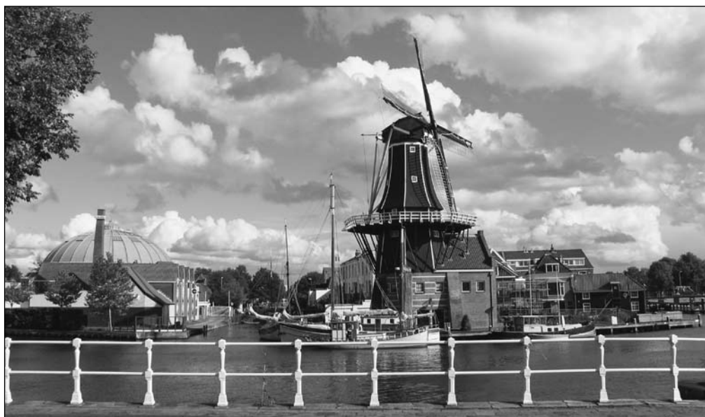
Sinds 2002 staat de herbouwde molen de Adriaan weer op de oude vertrouwde plek aan het Spaarne. (Foto: Vincent van Buuren)
