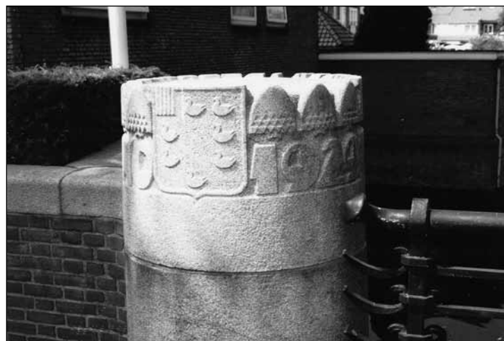
Kolom aan de westzijde van de Zandvaartbrug, gebouwd in 1929. (Foto V.C. Klep)
