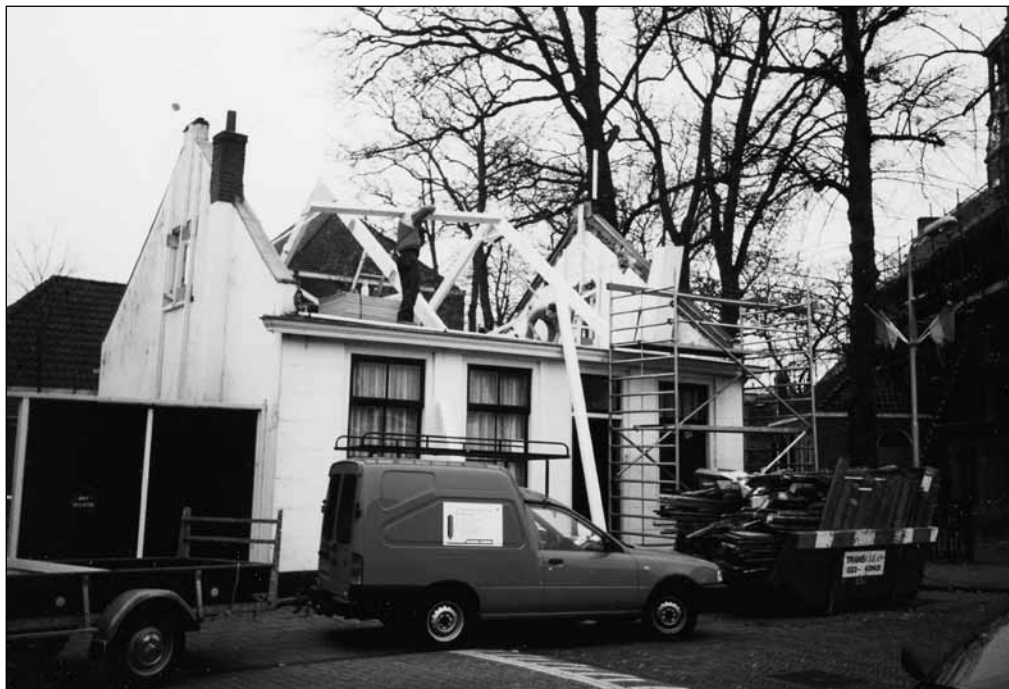
De ingrijpende verbouwing aan Achterweg nummer 17. Het hele dak ging er af.
