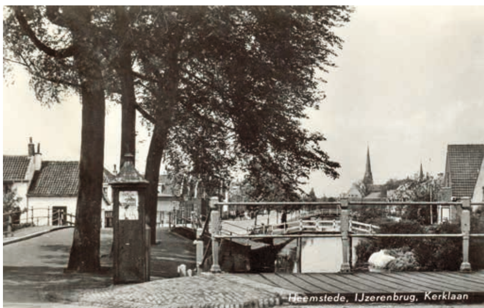
▲ Op deze foto, genomen vanaf de IJzeren Brug in 1966, zien we een woud van bruggen. Links de Witte Brug, die een jaar later gesloopt zou worden. Over het water zijn twee kwakels te zien. Het voorste houten bruggetje ging naar Kerklaan 2, 4 en 6. Op nummer 2 woonde omstreeks 1915 kruidenier Waasdorp, rond 1950 groentehandelaar Lenaarts. Nu ligt hier het parkeerterrein van de Dekamarkt, het bruggetje is verdwenen. De woning op nummer 6 is blijven staan, maar is alleen nog via de Lijsterbeslaan te bereiken. De tweede kwakel is er nog steeds, deze verbindt de Kerklaan met de Esdoornkade.
