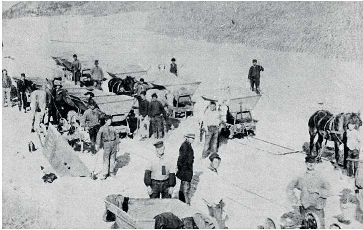
▲ Het graven van kanalen. Het zand wordt afgevoerd in kiepwagens, voortgetrokken door paarden.
