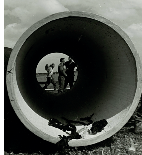
▲ Manshoge waterleidingbuis van de WRK-1 om water uit de Lek naar de Waterleidingduinen te transporteren. Deze WRK-1 leiding loopt dwars door het wandelpark Groenendaal onder de Beukenlaan door, gemarkeerd met paaltjes WRK-1 (Watertransportmaatschappij Rijn-Kennemerland).
