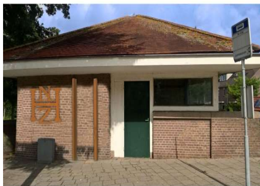
Tramhuisje Glipper brug met nog niet gerealiseerd ontwerp Henk Koelemeijer
