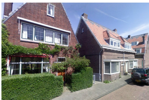
Nicolaas Beetslaan "eigenlijk een voorbeeld van vroeg suburbane bouw"
