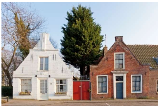
Links: Nummer 72 en 70 (rechts) zijn, met toestemming van RCE gesloopt. Nr. 70 - 66 wordt thans ontwikkeld met nieuwe woningen waarbij nr 72 wel in de oorspronkelijke stijl wordt herbouwd
