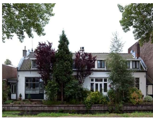
Woningen aan de Blekersvaartweg
