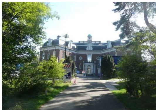
Mariënheuvel in renovatie Chateauform
