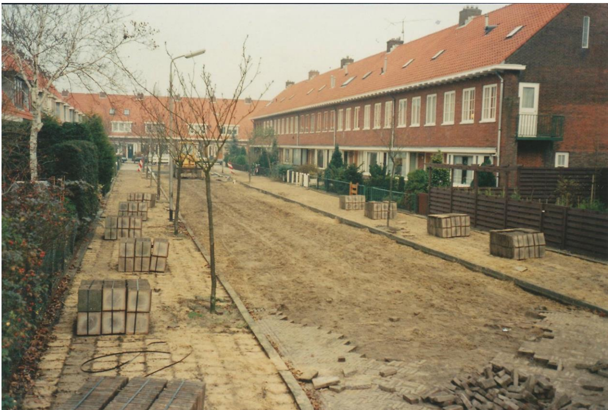
Soendastraat, herinrichting trottoirs. De wijk werd in fasen op de schop genomen, de Soendastraat was als laatste in 1990 aan de beurt. De boompjes zijn inmiddels al weer een keer vervangen door moeraseiken.
