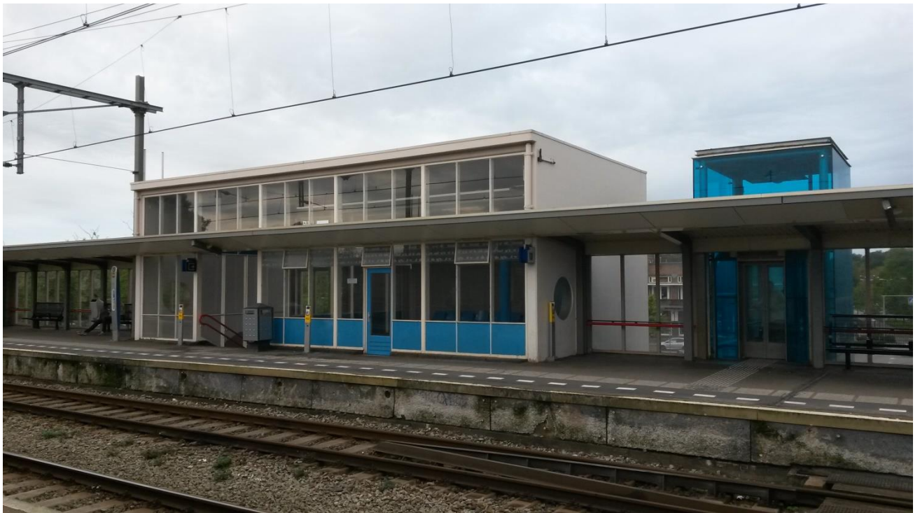
NS Station, perrongebouw aan de westzijde, huidige toestand.
