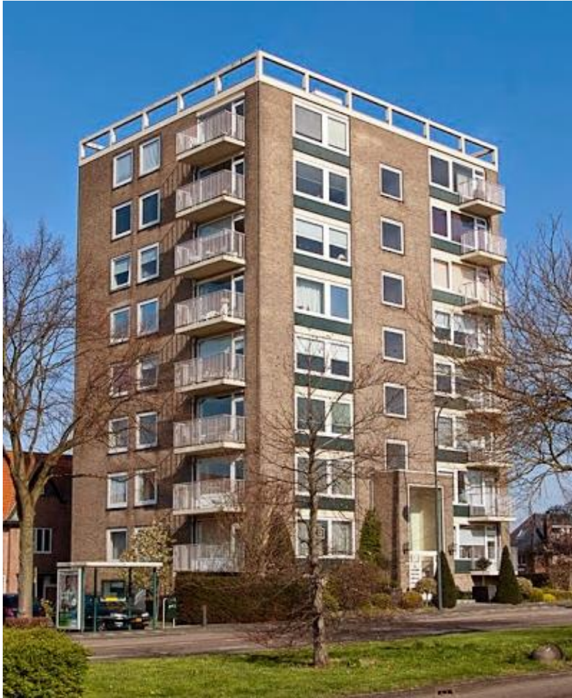
Flatgebouw, gezien vanuit het zuidoosten, huidige toestand.
