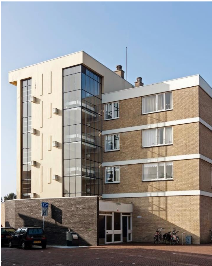
Zijgevel met trappenhuis en liftschacht, huidige toestand.
