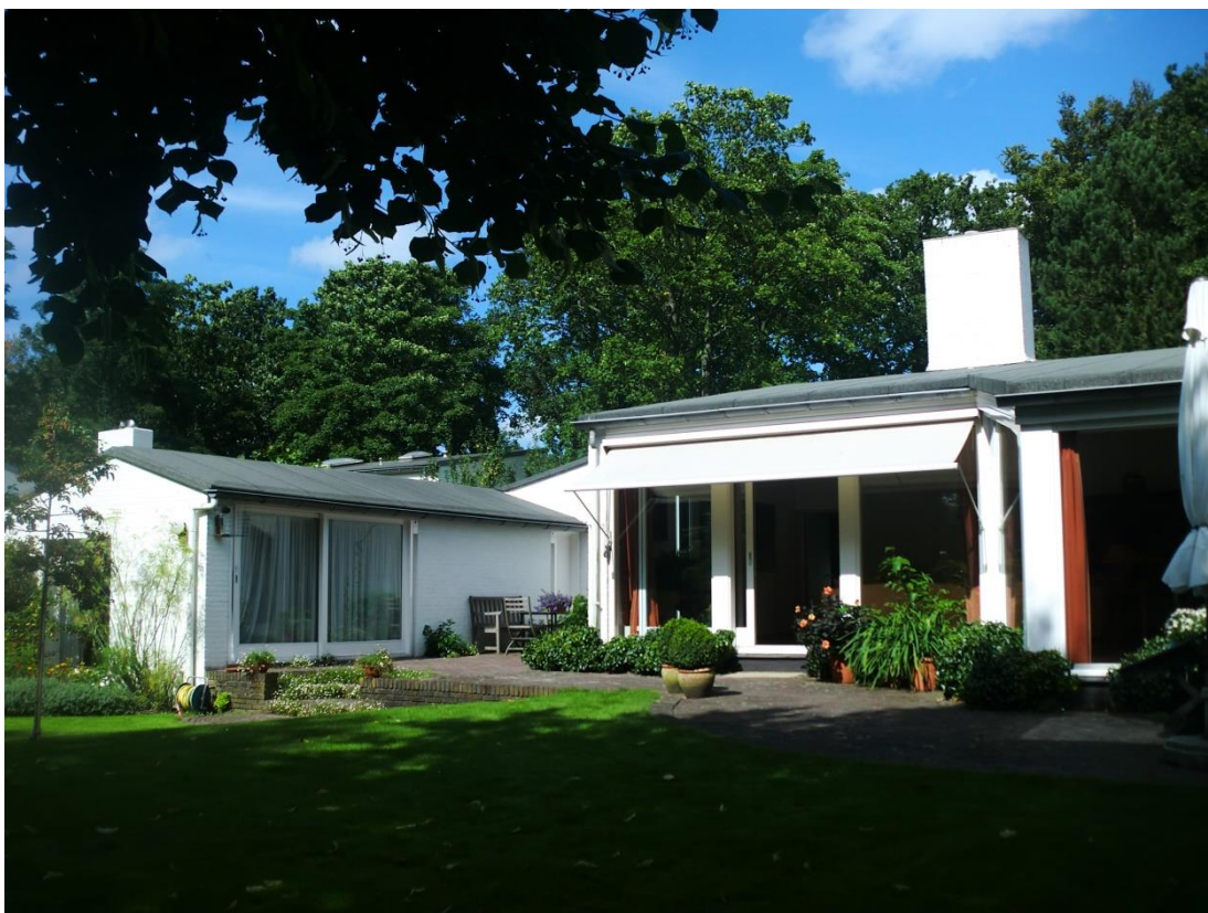
Achtergevel met links de uitbreiding uit 1972-1973, huidige toestand.
