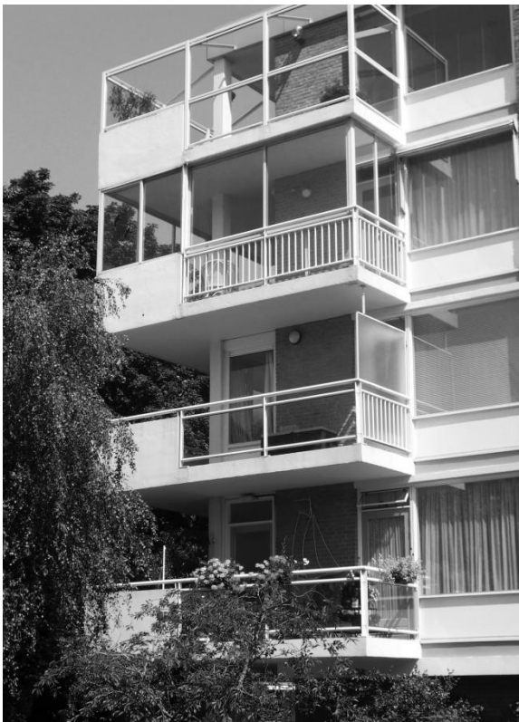
Flatgebouw Valkenburg, zijgevel met terrasbalkons, huidige toestand.
