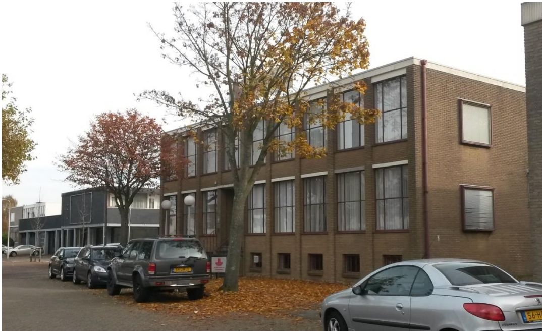
Reparatiewerkplaats met kantoor en woning, voorgevel, huidige toestand.
