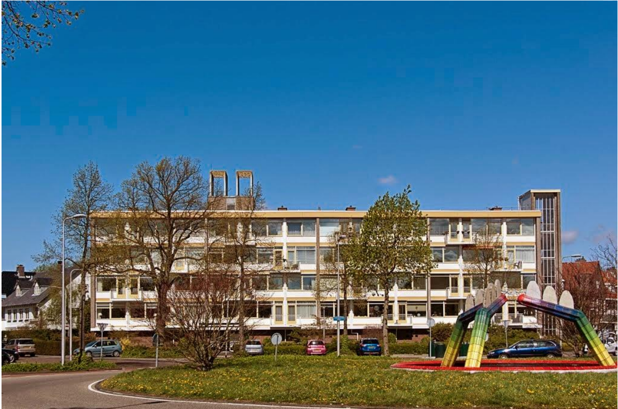
Flatgebouw Valkenburg, voorgevel, huidige toestand.
