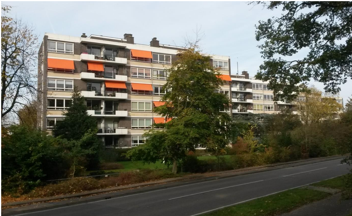
De meest zuidelijke van de drie blokken flatwoningen, gezien vanaf de Herenweg, huidige toestand.
