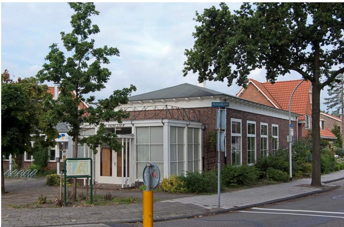
De Princehof, voor- en zijgevel van het zaalgedeelte, huidige toestand.
