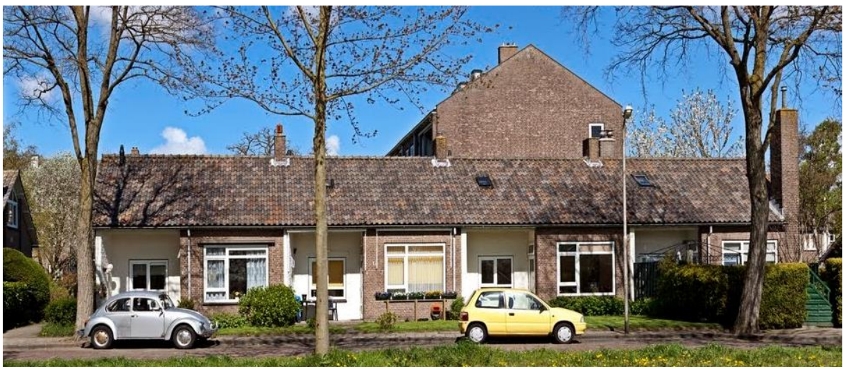
Laagbouwwoningen aan de Ringvaartlaan, huidige toestand.
