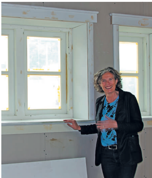
▲ Architect Taetske van Dijk legt uit: De architraven boven de oude ramen zijn, na isolatie van de muren, weer teruggebracht. Door extra dun isolatieglas te gebruiken kon de roedeverdeling behouden blijven.
