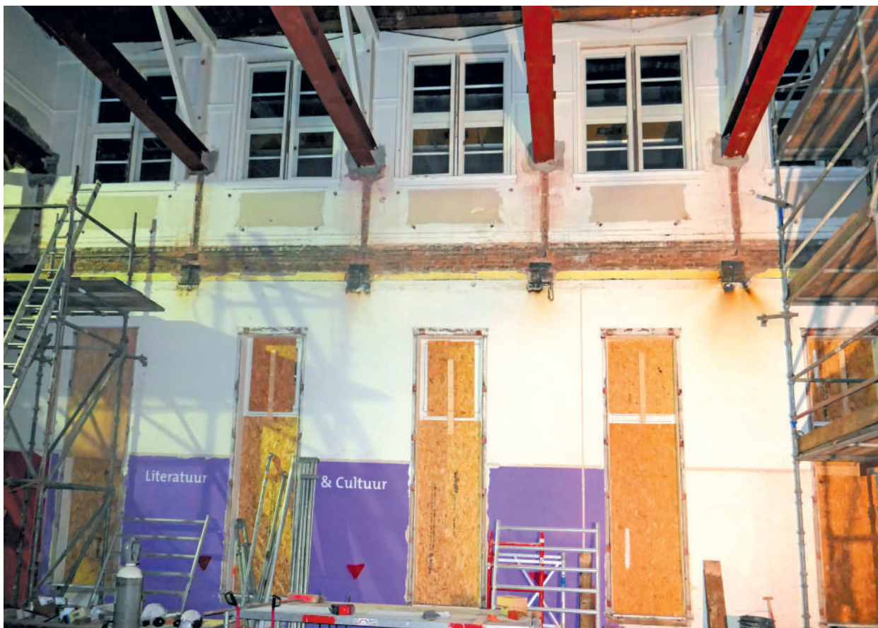
▲ Tijdens de verbouwing in december 2017. Op de muur is te zien, waar het plafond van de oude bibliotheekruimte (gymzaal) heeft gezeten. Op rode stalen balken komt de vloer van de zolderverdieping, lager wordt nog de vloer van de eerste verdieping aangebracht. Om niet met de ramen 'in de knoop te komen' zullen de vloeren niet tot aan de buitenmuur doorlopen. Er komen glazen zijwanden.
