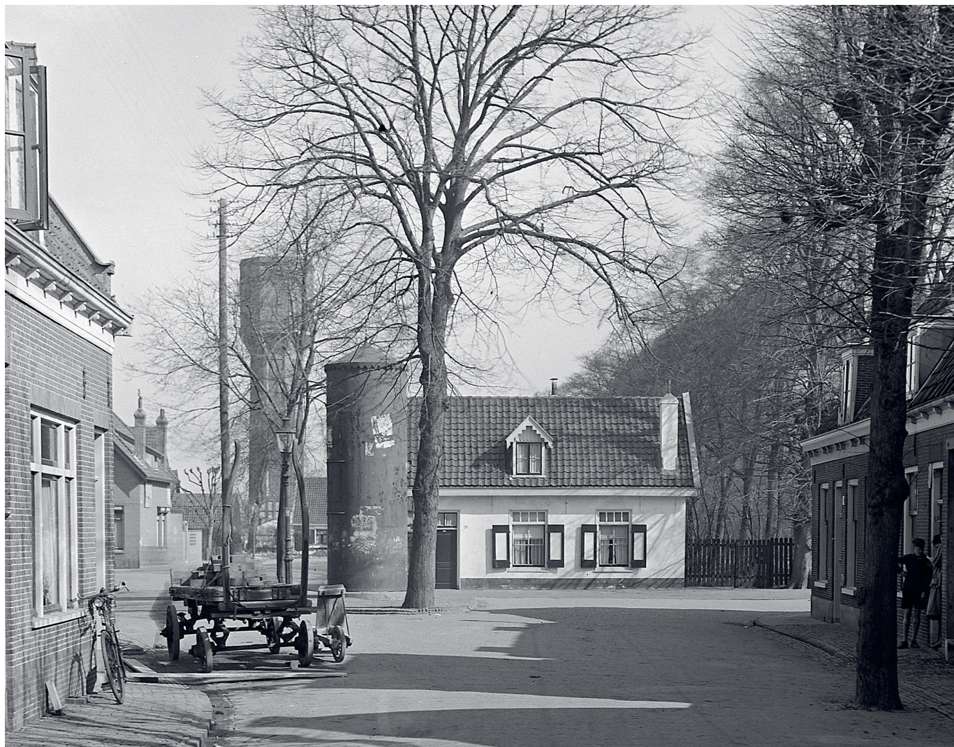
▲ De transformatorzuil aan de Cloosterweg in 1932. Dezelfde plek werd in 1933 opnieuw gefotografeerd. Het vervangen van de oude zuil door een nieuw huisje was een voorbeeld van de vooruitgang van Heemstede en werd daarom vastgelegd in de serie glasnegatieven, die de gemeente in die tijd maakte.
