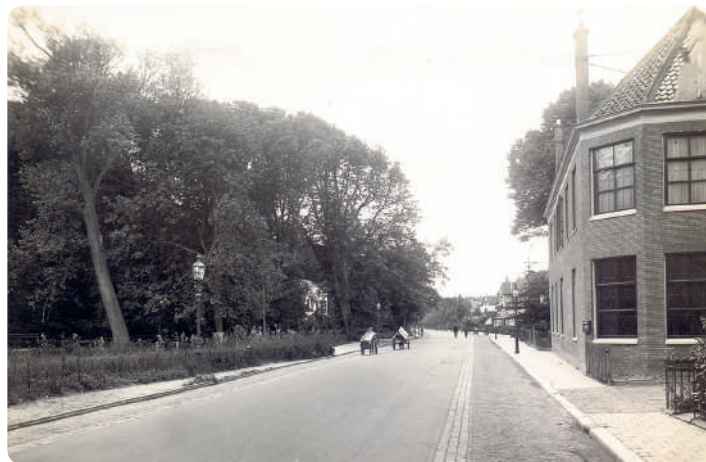
▲ Dezelfde plek na de verbetering. De rijbaan is verbreed en geasfalteerd met een band van kinderhoofdjes erlangs. Daarnaast aan weerszijden een fietspad van klinkers en een stoep. Het huis Bosch en Vaart werd in 1930 gesloopt.
