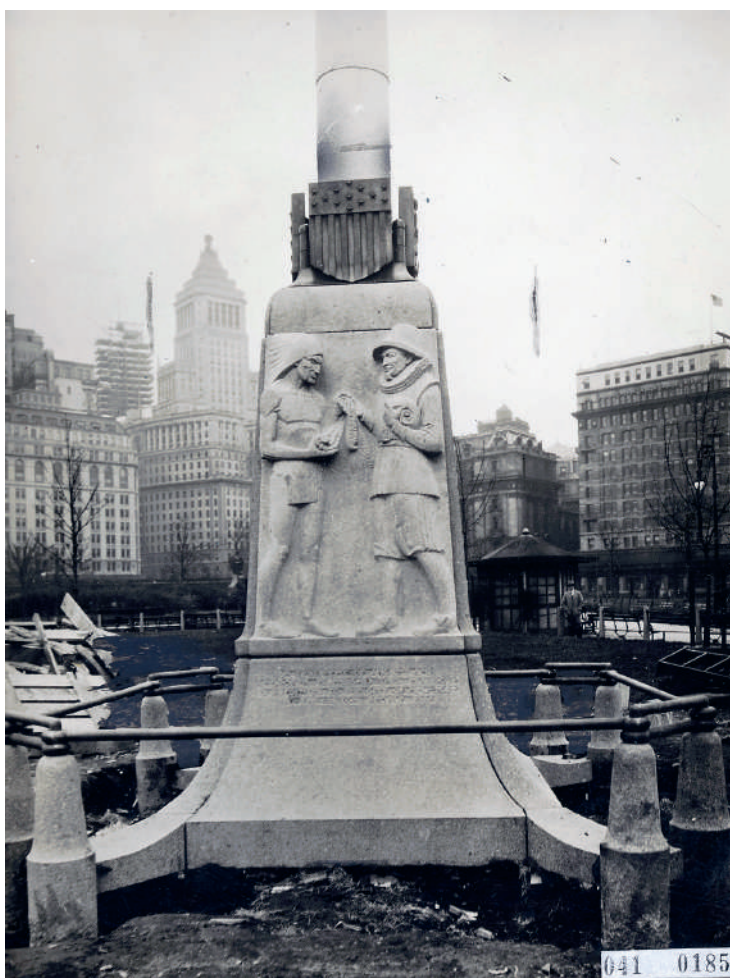
▲ Holland-monument, 1926. Battery Park, New York. Voetstuk van Beiers graniet (4 meter hoog), daarboven een stalen scheepsmast van 22 meter hoog.
