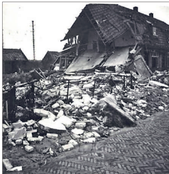
▲ De percelen Leidsevaart 164, 166, 168, 170, 172 en 174 waren op 14 maart 1945 zo beschadigd, dat ze meteen ontruimd moesten worden. Overige huizen in de omgeving liepen glas- en dakpanschade op. De Traliebrug bleef ongeschonden.
