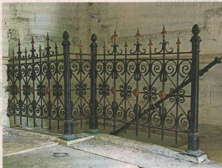
Het hekwerk bij de trap naar de kelder.
