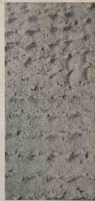
Fig. 10. Goed in het ruw gezet rietwerk
