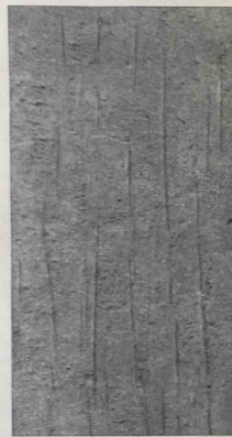
Fig. 9. Onvoldoende in het ruw gezet rietwerk
