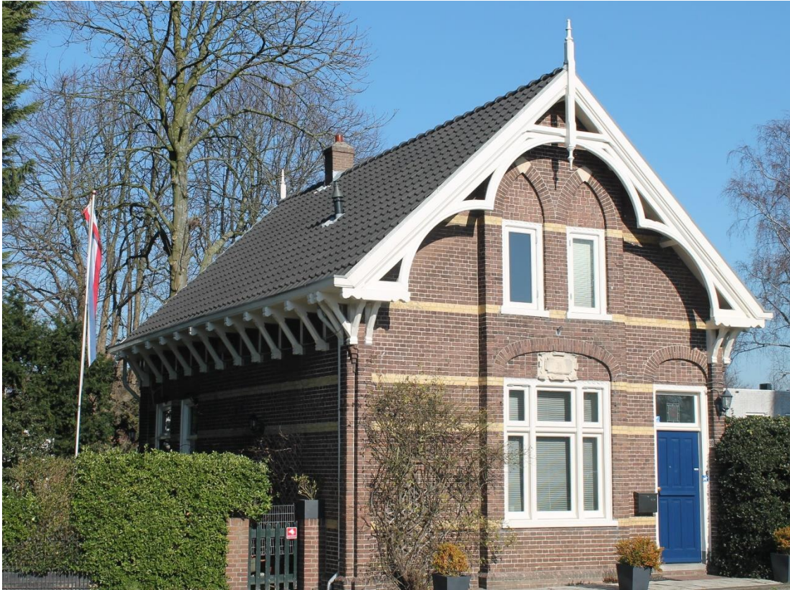
Woning van de beheerder van het kerkhof, gebouwd in 1886. Foto 2019.
