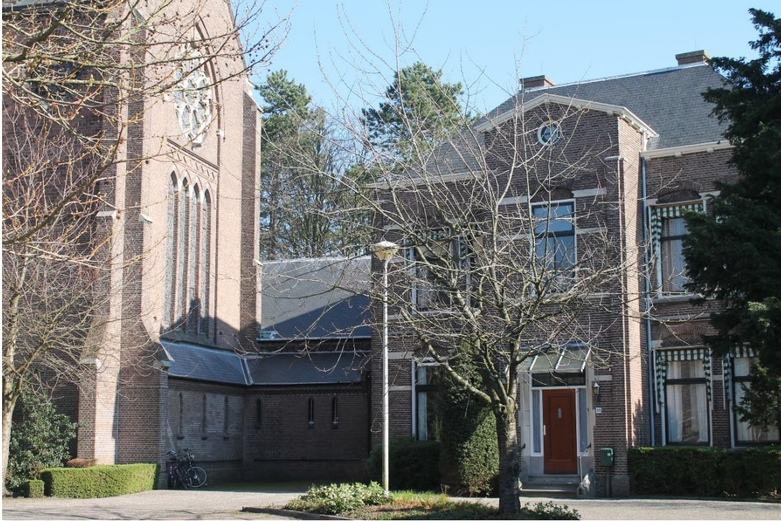
De pastorie is verbonden met het kerkgebouw. Foto 2019.
