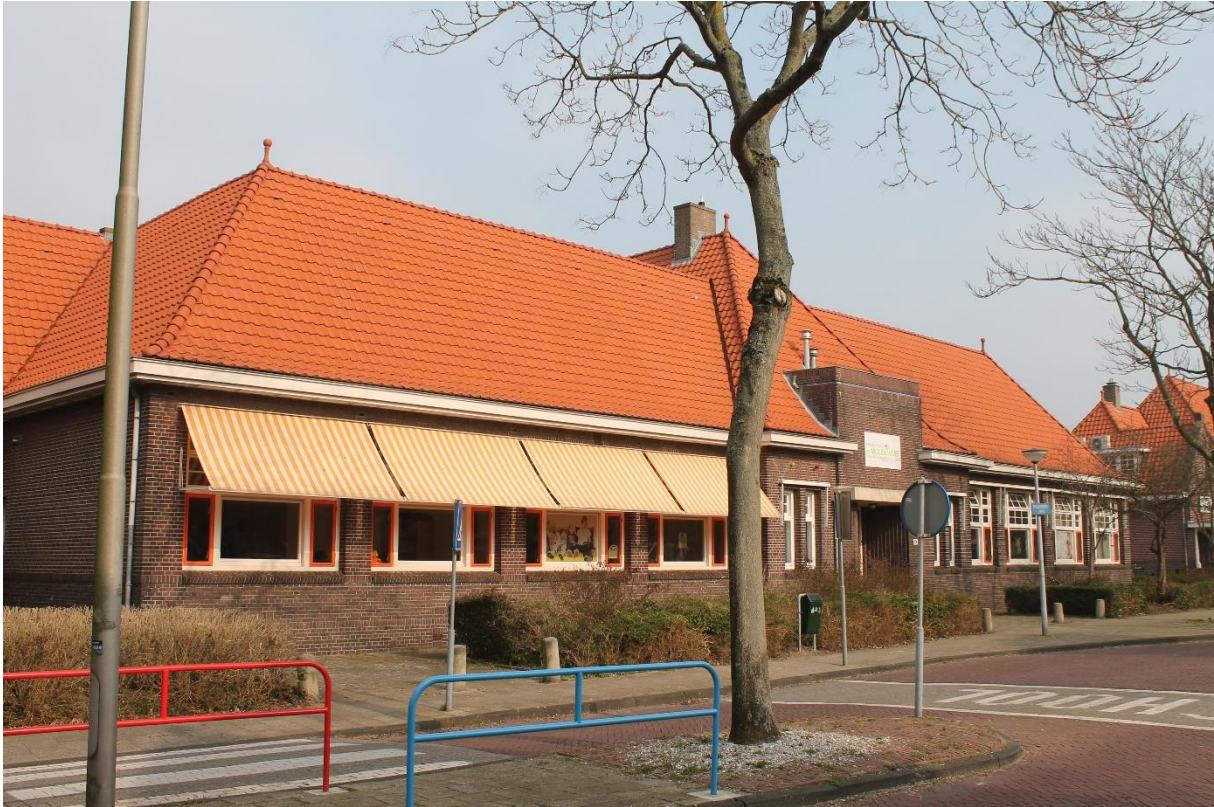
De St. Augustinusschool werd als eerste school van het ensemble gebouwd in 1925. Foto 2019.
