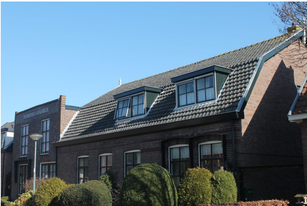
Voorgevel met woonhuis op de voorgrond. Foto 2019.
