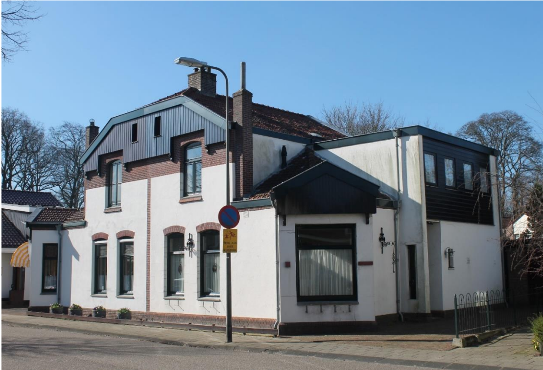
Oost- en noordgevel. Foto 2019.
