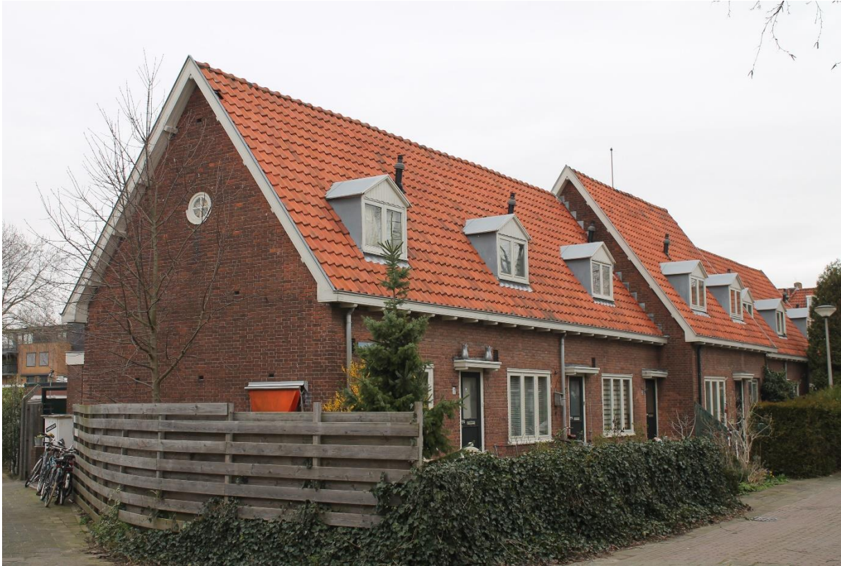
De noordelijke strook, met de vroegere woning van de wijkzuster in het iets hogere en naar voren stekende deel. Foto 2019.
