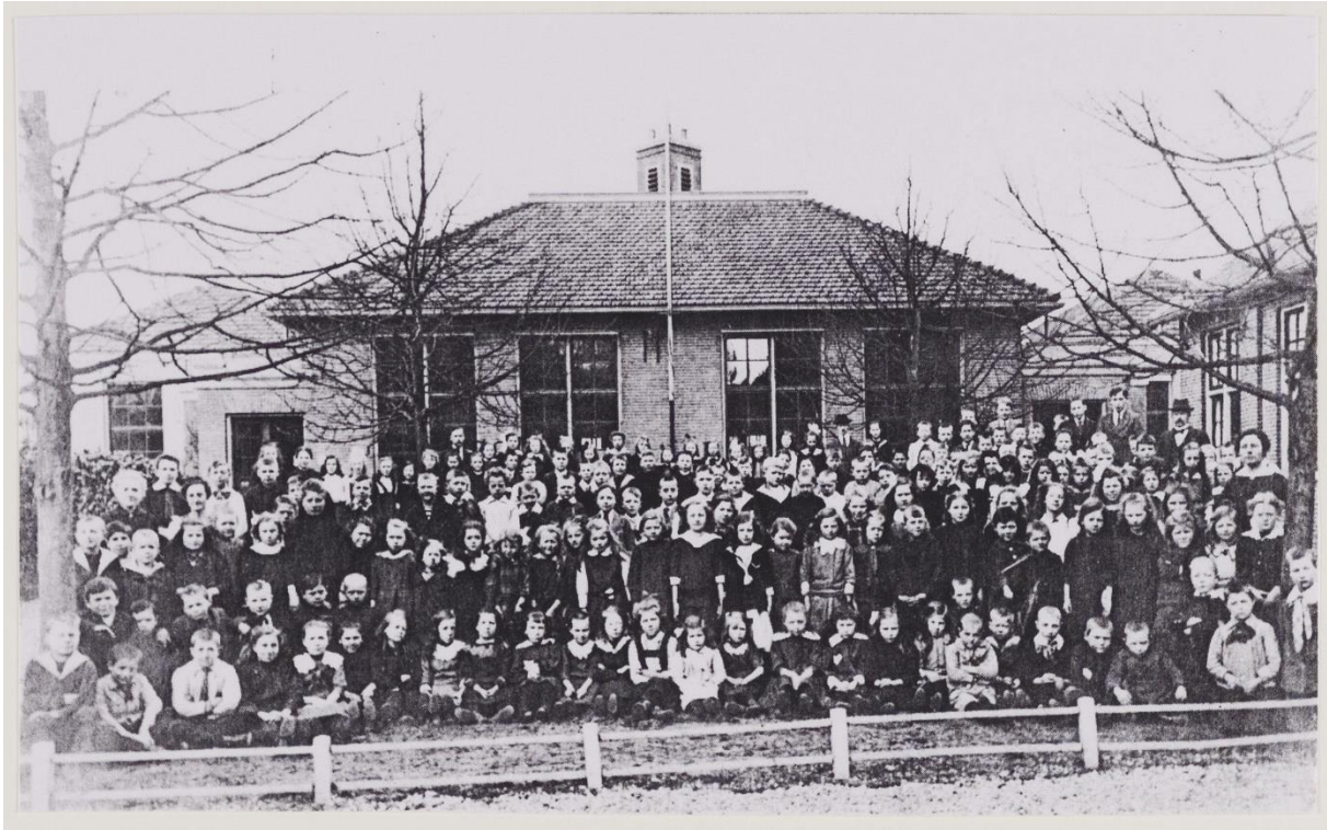
Leerlingen van de Nicolaas Beetschool voor het gebouw uit 1904-1905. Foto ca. 1915.
