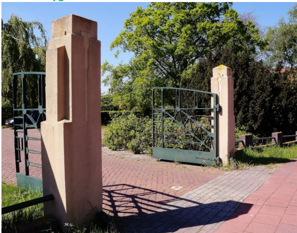
Aan de Leidsevaart staat het Waterleiding Pompgebouw, gebouwd in 1853. Precies tegenover de mooie Amstelbrug.
