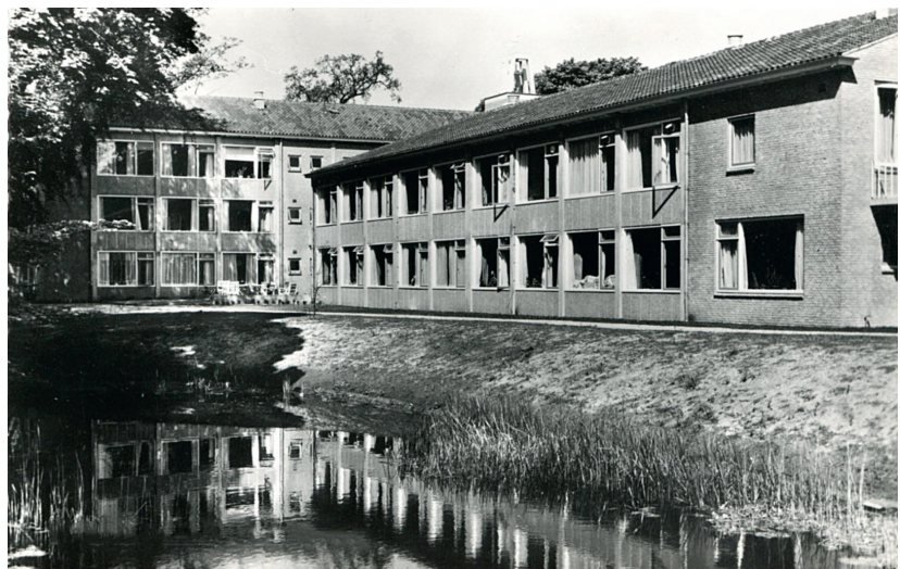
▲ Kennemeroord in 1961, in 2003 vervangen door luxe appartementen.
