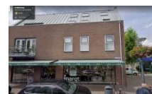
Afgebroken. Nu staat dit er, Marqt, met daarboven woningen.
