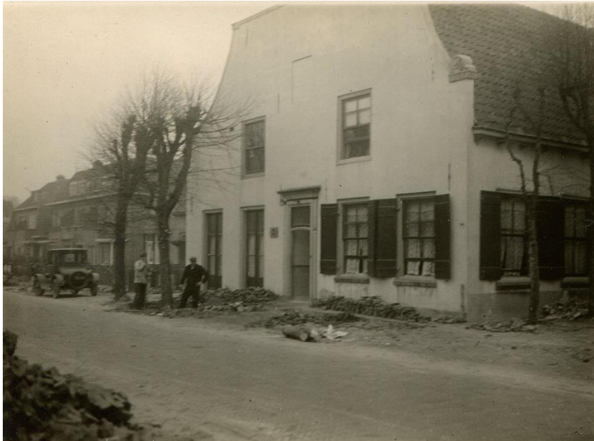
Het Oude Posthuis voor de verbouwing. De zuidgevel is hier nog niet gewijzigd. Foto collectie mw. C.H. Nijman-Draijer.
