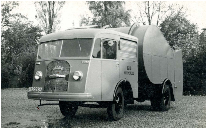
◀▲ Heemstedse vuilniswagen (boven) circa 1950. Chevrolet chassis, van een roltrommel voorzien door de firma Geesink uit Weesp. Als de bak achterin vol was, werd de trommel rechtop gekanteld (foto links) en viel die lading naar beneden. Zo kon de hele trommel effectief gevuld worden.
