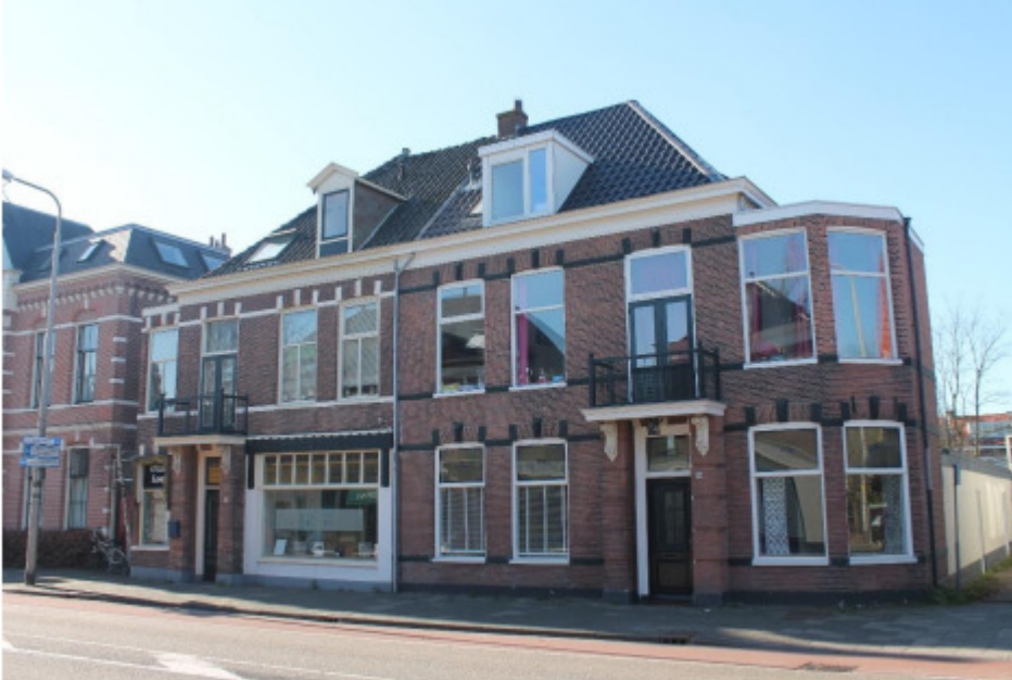
Het blok aan de westzijde van de Rijkstraatweg (nr. 39-41). Foto 2019.
