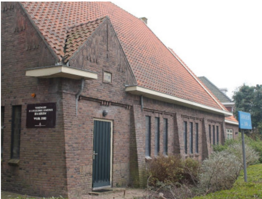
Zijgevel met gemetselde details aan de Lieven de Keylaan. Foto 2019.
