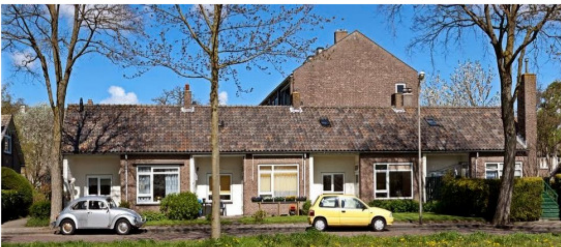
Laagbouwoningen aan de Ringvaartlaan, huidige toestand.
