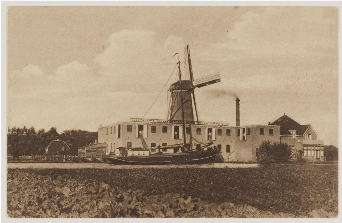
1910, zicht vanaf de (toen nog niet zo genoemde) Höckervaart (NHA). Dit is de tweede schoorsteen, gebouwd door Canoy-Herfkens. De eerste was uit 1853.
