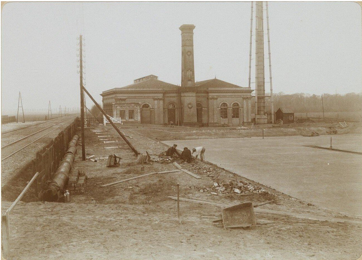
Het eerste pompstation Leiduin aan de Leidsevaartweg en de vierkante schoorsteen zijn gebouwd in 1853. Foto ca. 1900 (Stadsarchief Amsterdam). De hoge standpijp regelde de waterdruk en is dus geen schoorsteen. Links het spoor.
