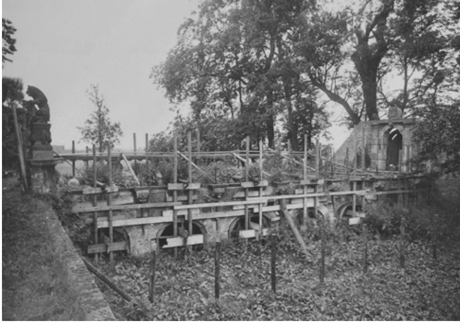
◀ De gestutte brug in 1950. Het bovendeel van de brug was opgeslagen. De leeuwen staan er hier nog wel.
