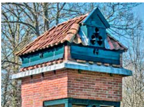
▲ 19de-eeuws duivenzoldertje boven een secreet bij de Fraeylemaborg in Slochteren. In het opstaande geveltje onder de driehoek zitten drie invliegopeningen.
