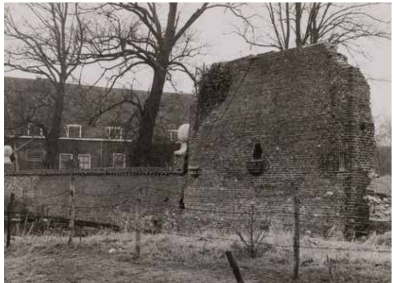
▲ De zuidwestgevel van de duivenpoort na de instorting, 1959.
